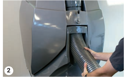
Anschrauben des Saugschlauches
