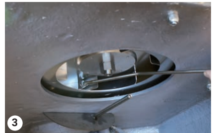
3 Reinigung der Turbine
