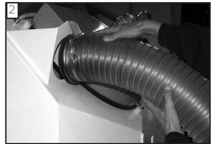
Die Ansaugleitung wird abmontiert
