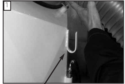
Einhängebügel für Hydraulik- und Wasserschläuche.
