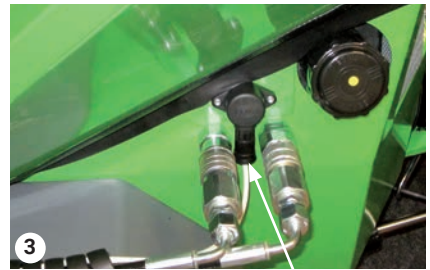
Hydraulikschläuche und Stromstecker montieren
