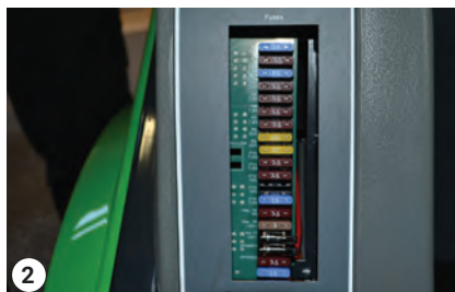
Sikringer – kabinegulv, højre side
